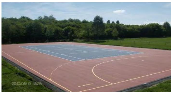
II. Pavimentos de dureza mejorada o semirrígidos: cuentan con un grado mínimo de elasticidad. Reducida capacidad de absorción de impactos.
